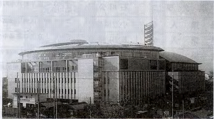
オープン近い京都府民総合交流プラザ
